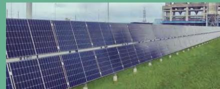
A UAB Orion Global PET, nossa subsidiária na Lituânia, instalou uma central de energia solar no lugar de uma vedação, que desempenha a dupla função de demarcar o limite e gerar 55,82 MWh de eletricidade por ano, elevando a capacidade total de produção de energia solar no local para 390.000 kWh.
