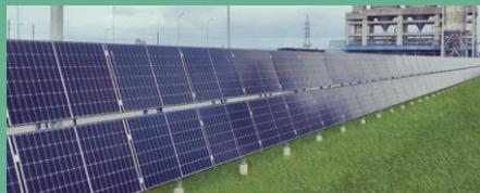
UAB Orion Global PET，是我们在立陶宛的子公司，安装了一套太阳能发电装置来代替围栏，发挥着边界标记和发电的双重功能，年发电量为 55.82MWh，使公司总太阳能产能达 390,000kWh。
